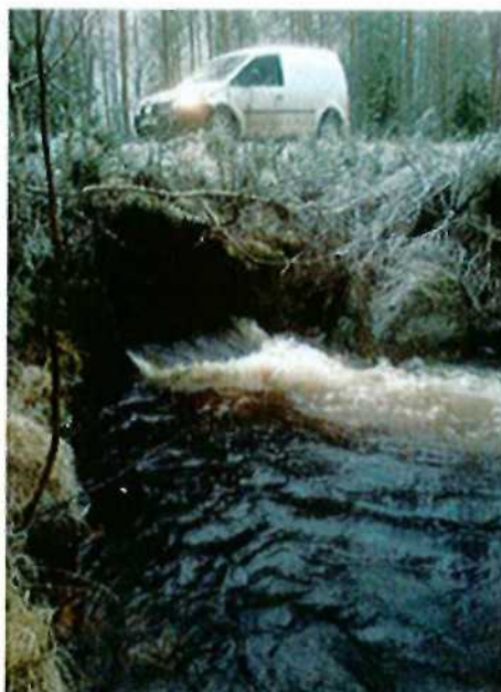
Foto. Provtagningsplats för både vattenkemi och elfiske i Kvarnbäcken (uppströms trumman). Noterbart är att trumman är i behov av att åtgärdas då den utgör vandringshinder. Trumman är både är underdimensionerad och för högt placerad. Foto Tord Matsson
